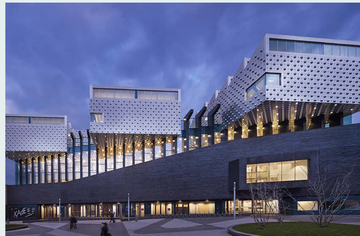
Nieuwbouw multifunctioneel cultureel centrum Eemhuis Amersfoort (2013) — Het Eemhuis is het culturele centrum van Amersfoort, ontworpen door Neutelings Riedijk Architecten en gebouwd door Dura Vermeer. Het Eemhuis biedt huisvesting aan onder meer een archief, bibliotheek, kunsthuis en school in een bijzonder inspirerende omgeving.
