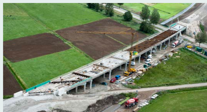
Aanleg Hanzelijn, Oudeland Kampen (2009) — In 2009 werkt Dura Vermeer mee aan de bouw van de Hanzelijn, een nieuwe vijftig kilometer lange spoorverbinding tussen Lelystad en Zwolle. Het bedrijf realiseert de aanleg van de onderbouw Hanzelijn Oudeland, in totaal vijftien kilometer spoorbaan.
