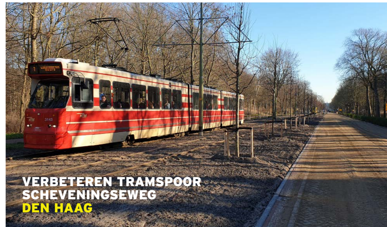
Opdrachtgever Gemeente Den Haag Bijzonderheden Spoor, bovenleiding, seinwezen en alle langslopende en kruisende wegen zijn vervangen en volledig opnieuw ingericht vanwege de nieuwe, zwaardere tramvoertuigen.
