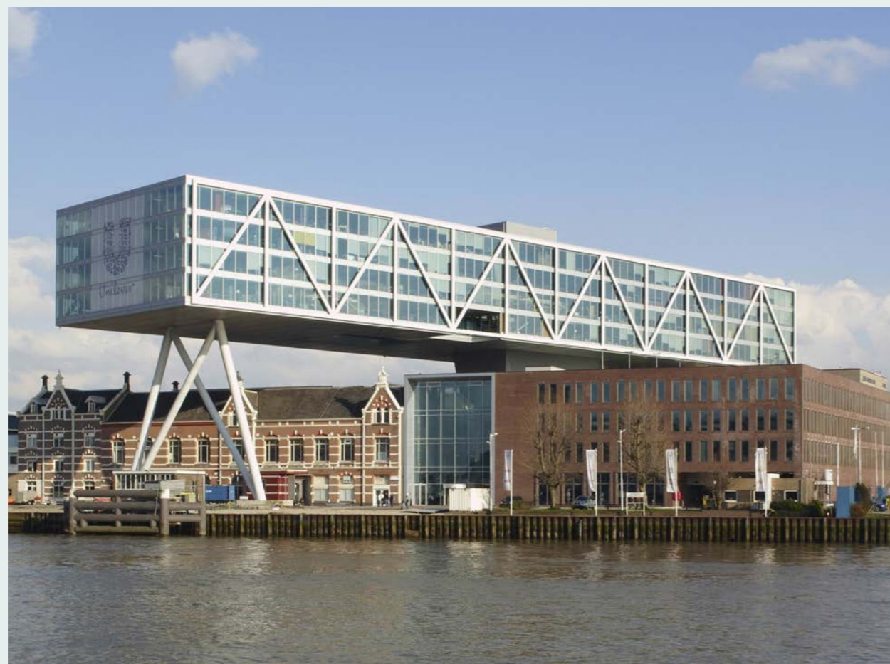
Nieuwe hoofdkantoor Unilever 'De Brug', Rotterdam (2005) — Het nieuwe transparante bruggebouw van staal en glas is een spectaculair voorbeeld van prefabricatie en industrieel, flexibel en demontabel bouwen (IFD). De complete staalconstructie is naast de locatie in elkaar gezet en daarna op zijn definitieve plek geplaatst. Het hangt 26 meter boven het terrein van de Blue Bandfabriek.
