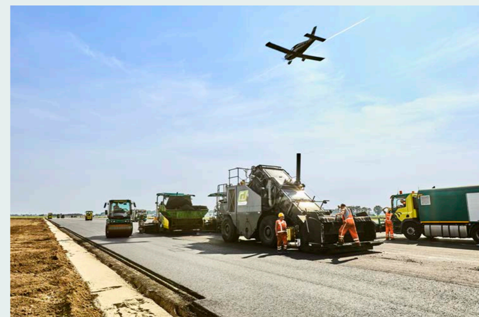
Aanleg infrastructuur Lelystad Airport (2018) — Dura Vermeer heeft op Lelystad Airport de huidige start- en landingsbaan verlengd en verbreed en zo duurzaam mogelijk ontwikkeld door hergebruik van grond, toepassing van innovatieve verlichting en samenwerking met lokale boeren.
