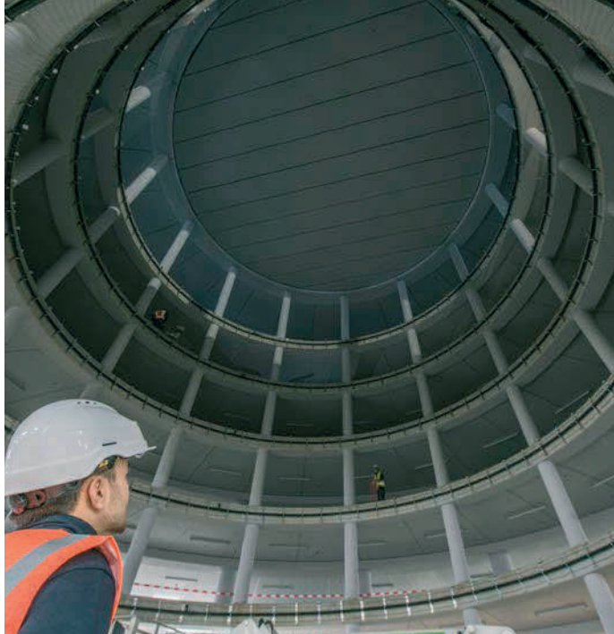
Parkeergarage Lammermarkt, Leiden
