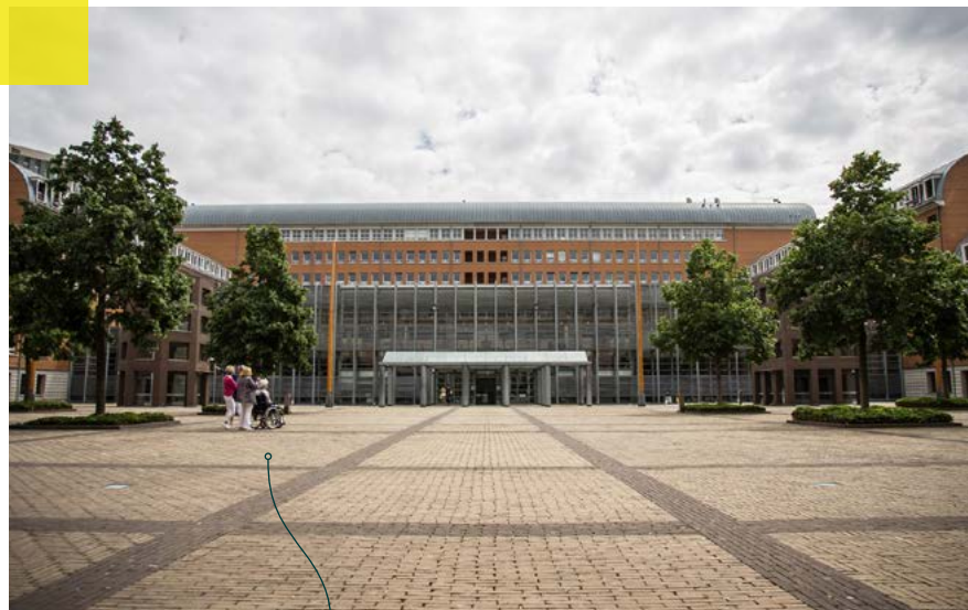
UTILITEITSBOUW 's-Hertogenbosch, Paleis van Justitie (renovatie i.s.m. Heyma)
