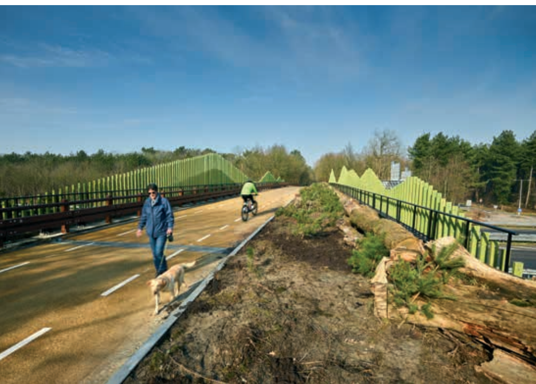
Route van de Turf, Bergen op Zoom Omschrijving Reconstructie fiets- en wandelpad en renovatie Zoomlandviaduct met biobased materialen. Opdrachtgever Gemeente Bergen op Zoom
